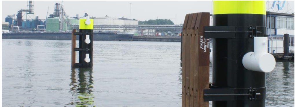
Figuur 3: referentiebeeld palen ter bescherming van de jachthaven (in deze situatie met bolders en wrijfstijlen) (Bron: Gebr. de Koning)
