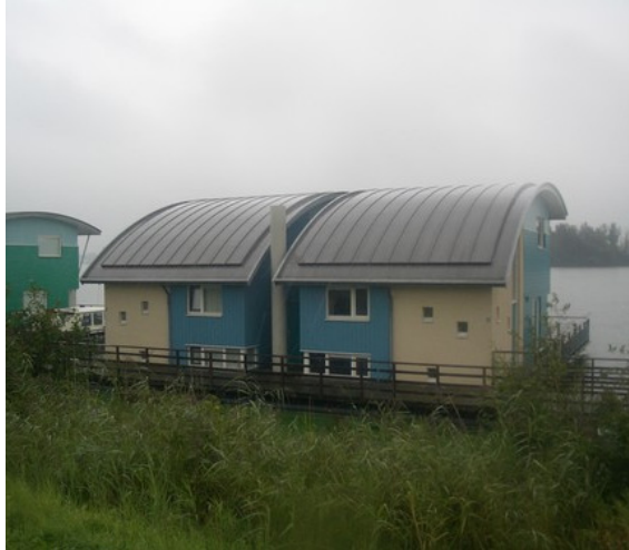
Figuur 4.14. Drijvende woningen zijn bevestigd aan meerpalen.
