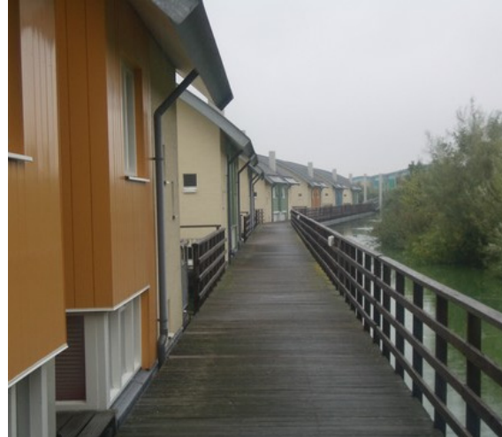
Figuur 4.15. De drijvende woningen zijn met een steiger verbonden met het vaste land.
