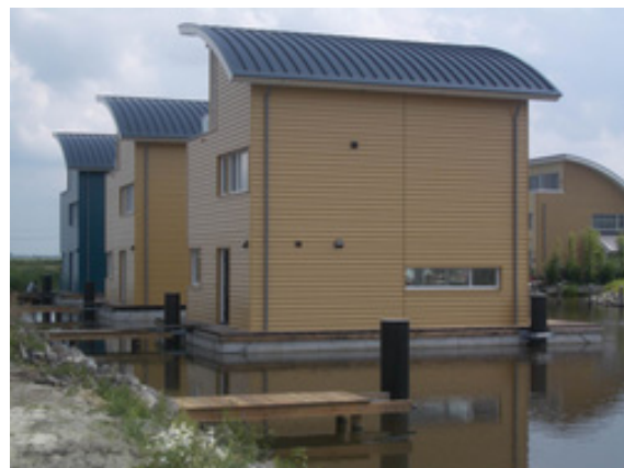
Figuur 4.7. De drijvende woningen worden op hun plaats gehouden door meerpalen.
